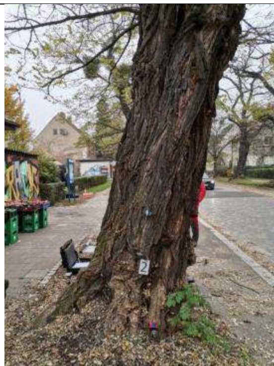
Fot. 6. Robinia, ul. Odkrywców 21a, Wrocław. Próba obciążeniowa - mocowania czujników — strona rozciągana
