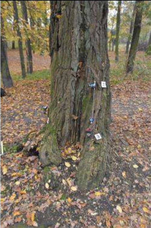
Fot. 7. Robinia 34-19, ul. Odkrywców przy parku, Wrocław. Próba obciążeniowa - miejsce mocowania czujników - strona ściskana
