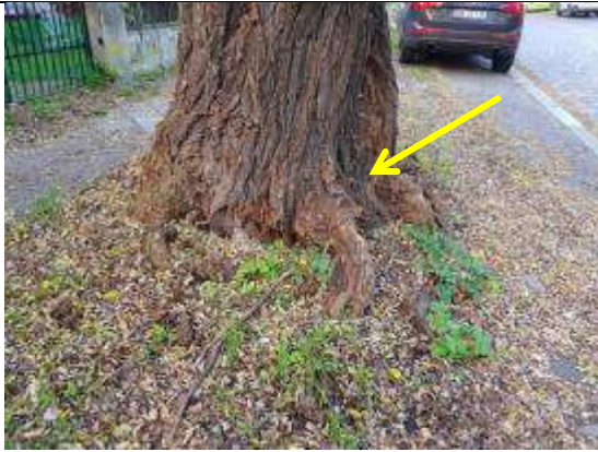
Fot. 3. Robinia 40-26, ul. Odkrywców 23, Wrocław. Uszkodzenia nabiegów
