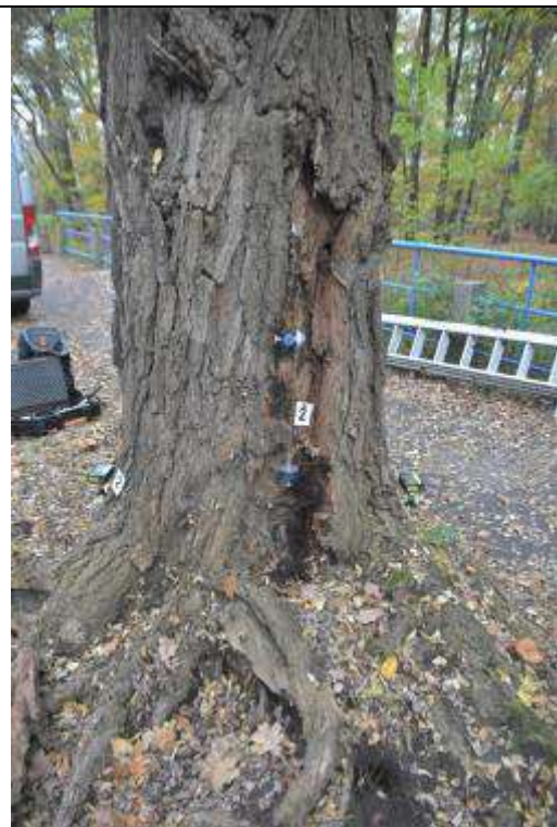
Fot. 8. Robinia 35-20, ul. Odkrywców przy parku od W, Wrocław. Próba obciążeniowa - miejsca mocowania czujników — strona rozciągana
