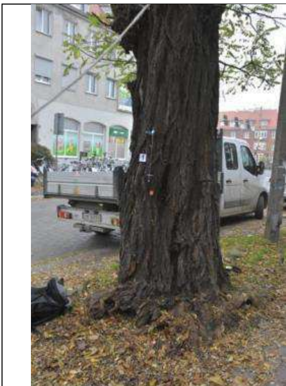
Fot. 9. Robinia 21-1, ul. Odkrywców 2a, Wrocław. Próba obciążeniowa - miejsce mocowania czujników - strona ściskana
