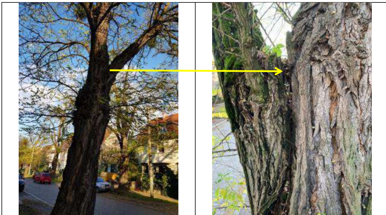
Fot. 7 i 8. Robinia 38-23, ul. Odkrywców 31-33, Wrocław. Przewodnik od ulicy ze słabym mocowaniem – pęknięcie.
