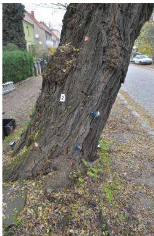
Fot. 6. Robinia 44-30, ul. Odkrywców 13 od S, Wrocław. Próba obciążeniowa - miejsce mocowania czujników — strona rozciągana
