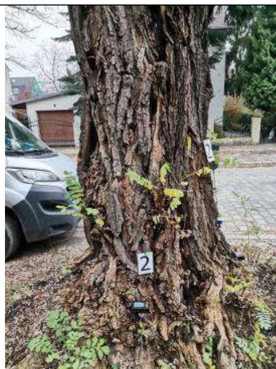
Fot. 6. Robinia 37-22, ul. Odkrywców 33, Wrocław. Próba obciążeniowa - miejsce mocowania czujników -- strona rozciągana
