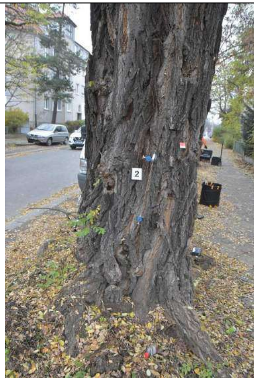
Fot. 8. Robinia 46-32, ul. Odkrywców 4, Wrocław. Próba obciążeniowa - miejsce mocowania czujników — strona rozciągana
