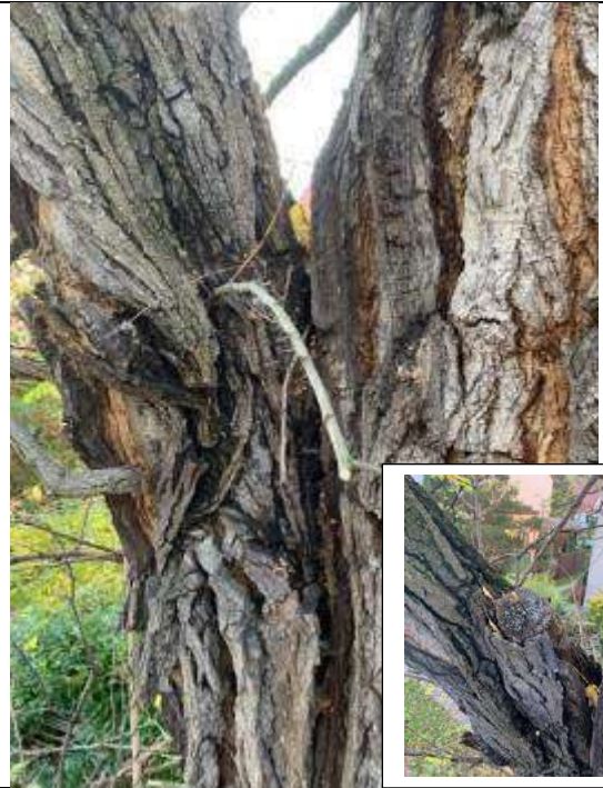
Fot. 8 Robinia 39-24, ul. Odkrywców 27, Wrocław Konar od ulicy w dolnym piętrze e słabym mocowaniem.
