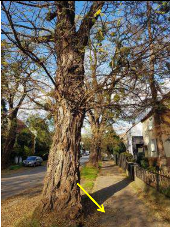
Fot. 3. Robinia 24-4, ul. Odkrywców 18, Wrocław. Płytki chodnika podniesione.
