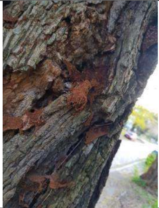
Fot. 4 Robinia 38-23, ul. Odkrywców 31-33, Wrocław. Trociczki na pniu świadczące o rozkładzie brunatnym
