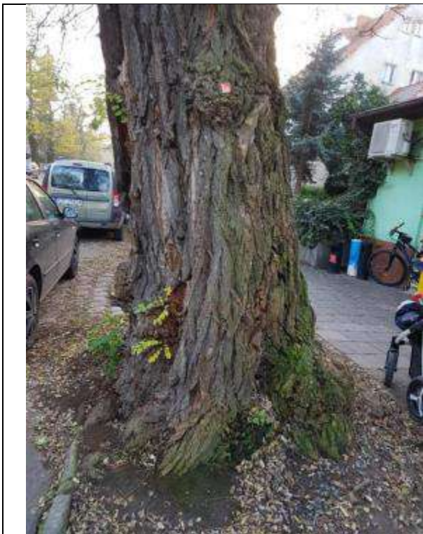
Fot. 3 Robinia 41-27, ul. Odkrywców 21a , Wrocław. Uszkodzenia nabiegów i pnia od strony ulicy
