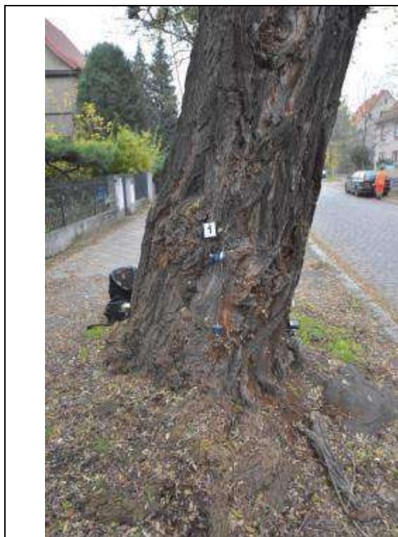
Fot. 7. Robinia 43-29, ul. Odkrywców 15, Wrocław. Próba obciążeniowa - miejsce mocowania czujników - strona ściskana
