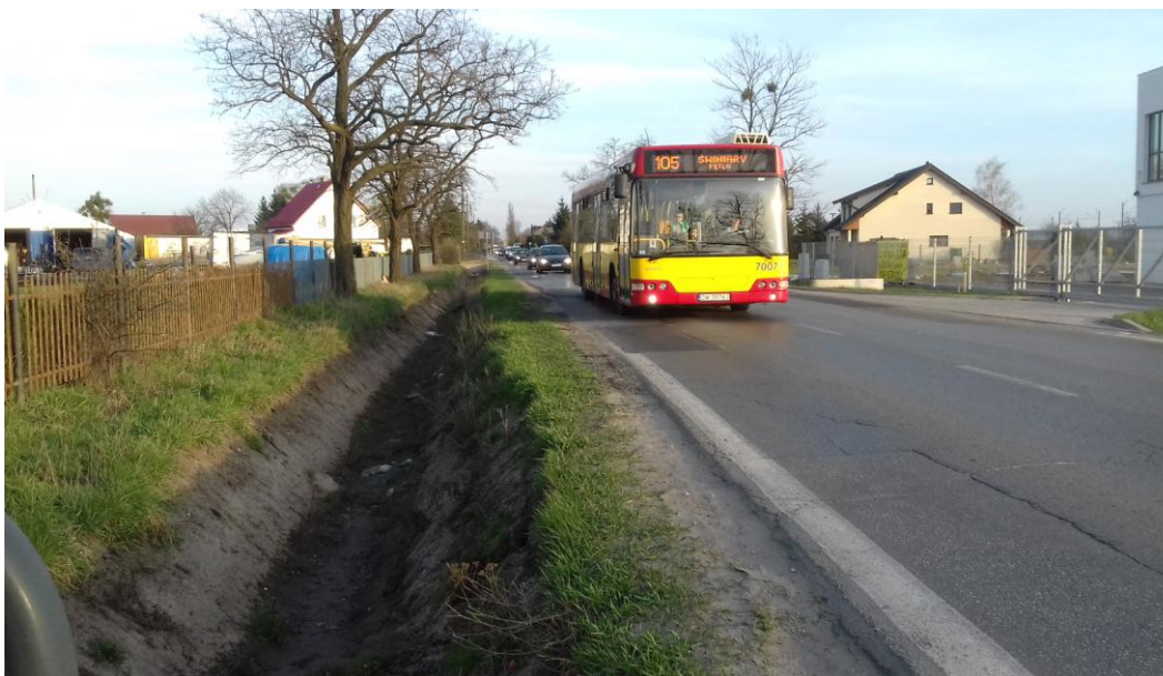
Fot. 2-8. Rowy melioracyjne wzdłuż jezdni po obu stronach ul. Pełczyńskiej na odcinku od ul. Kminkowej do ul. Perzowej, na terenie zabudowanym nie zaprojektowano żadnego chodnika ani drogi dla rowerów
