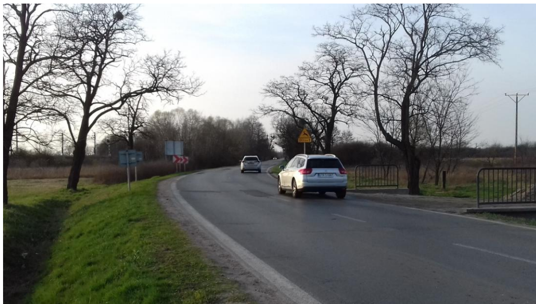
Fot. 1. Ciąg pieszo-rowerowy na ul. Zajączkowskiej między Świniarami i Lipą Piotrowską według projektu ma zakończyć się w tym miejscu, przed pierwszymi zabudowaniami przy ul. Pełczyńskiej
