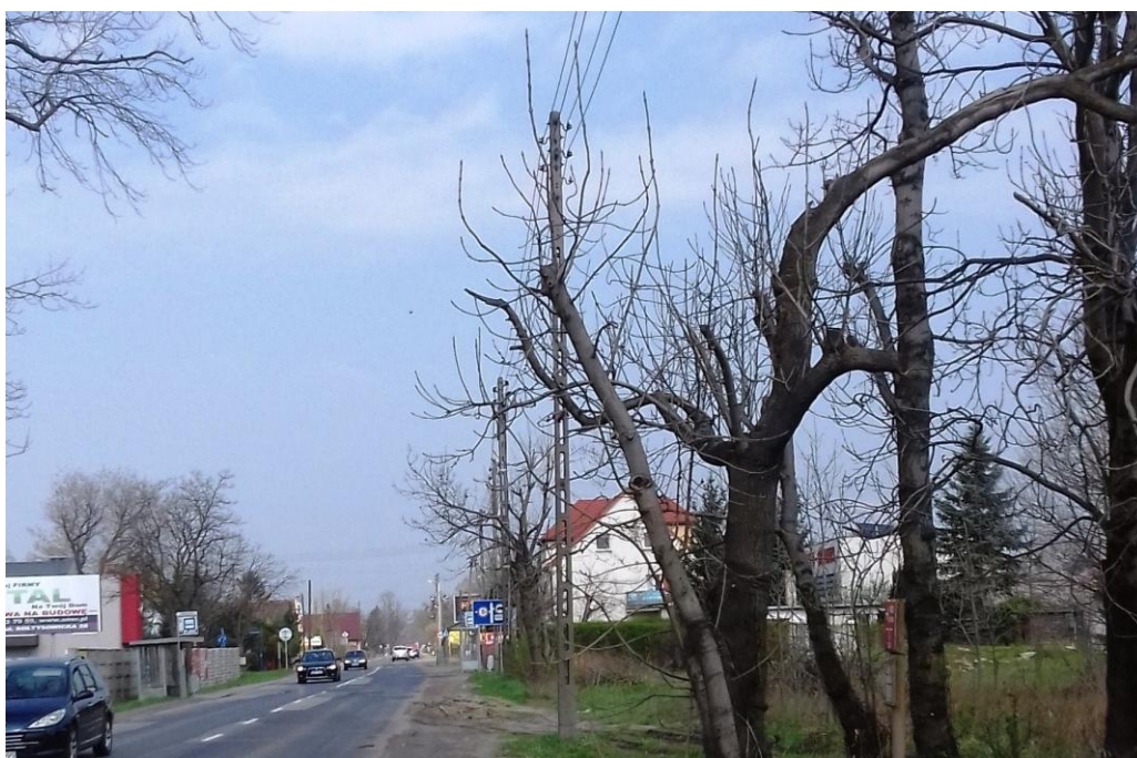
Fot. 14 Wymiana starych lamp i zastąpienie napowietrznych linii energetycznych liniami podziemnymi ma znaczenie nie tylko estetyczne, linie energetyczne kolidują z drzewami, a słupy stanowią barierę na chodnikach
