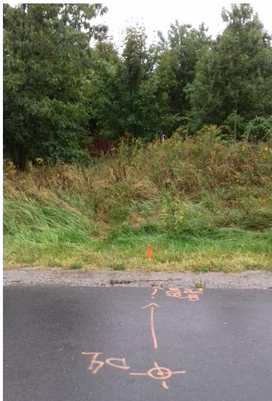
Fot. Działka 3/7 AR_5 obręb Lipa Piotrowska miejsce wytyczone pod budowę nowego rowu mającego pełnić funkcję odwodnienia ul. Cynamonowej – stan na 1.09.2017
