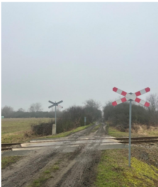
Fot. 1: Widok przejazdu od strony Wrocławia.
